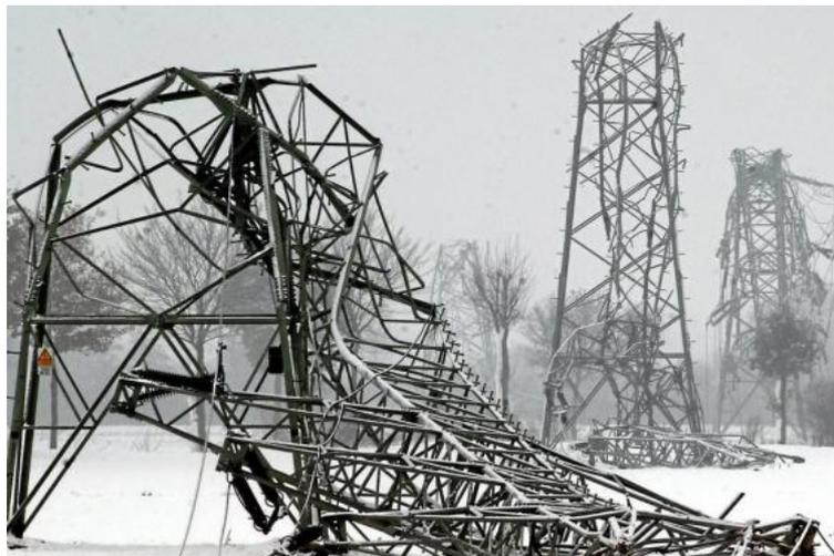
Abbildung 1.1: Zusammengebrochene Strommasten im Münsterland nach dem Starkschneefallereignis vom 25./26. November 2005 (Foto ©Münstersche Zeitung, 2005).
